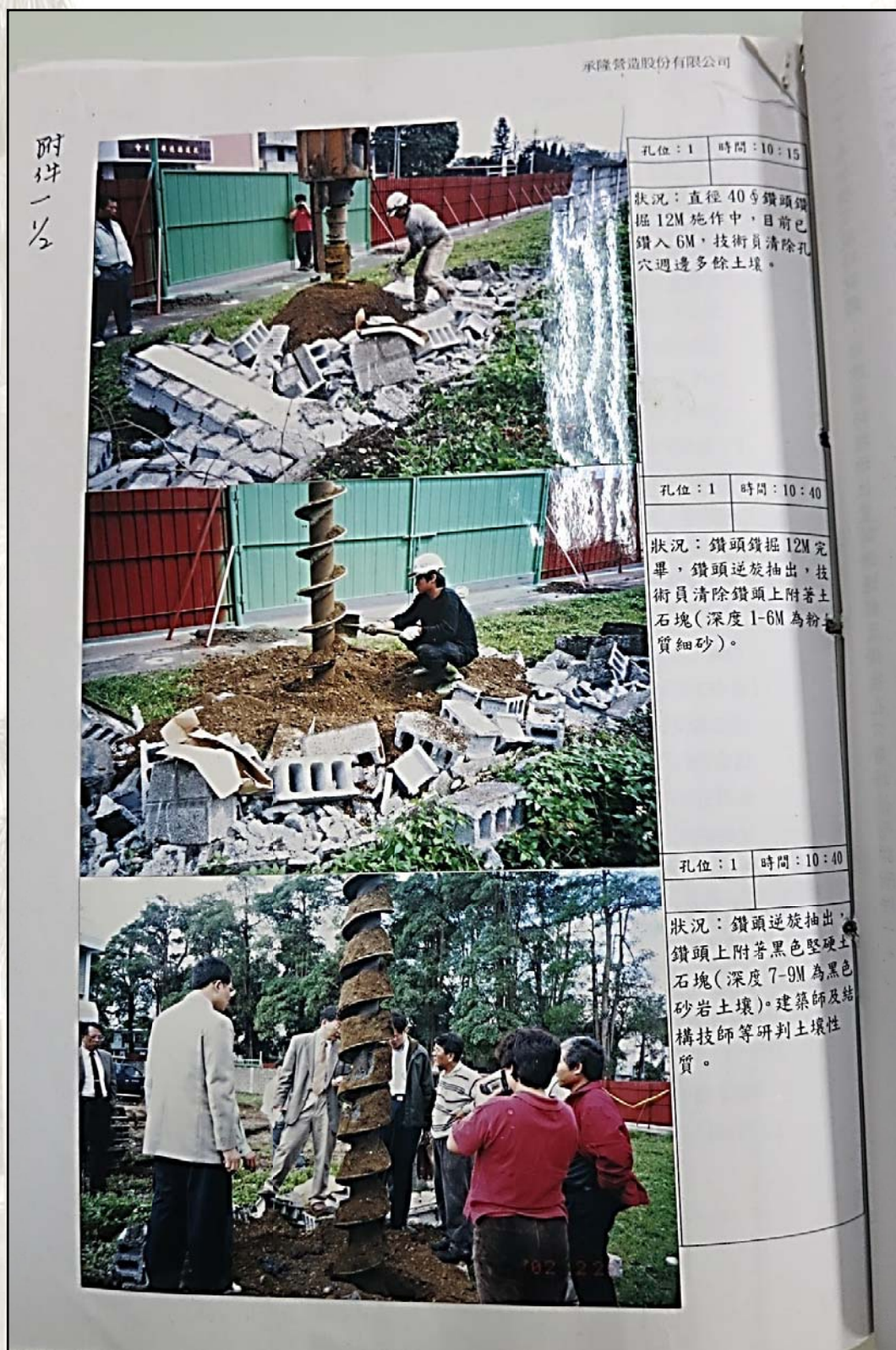
本署擴建辦公廳舍暨大型贓物庫新建工程擋土排樁試鑽紀錄
