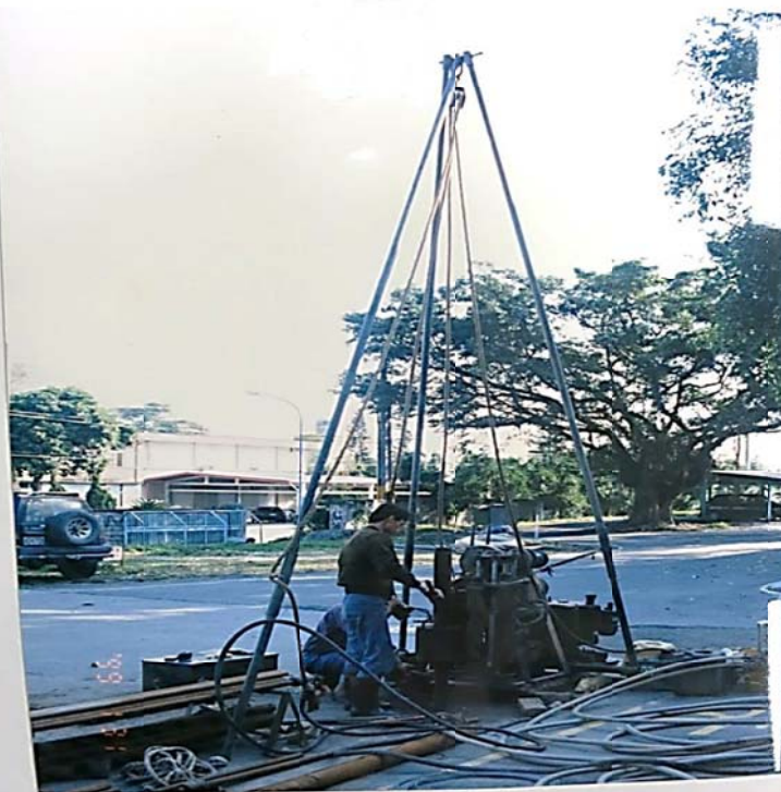
本署擴建辦公廳舍暨大型贓物庫新建工程基地測量工程之施作照片
