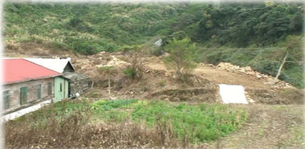
被告非法竊佔公有山坡地，使山坡地裸露(民國 98 年)
