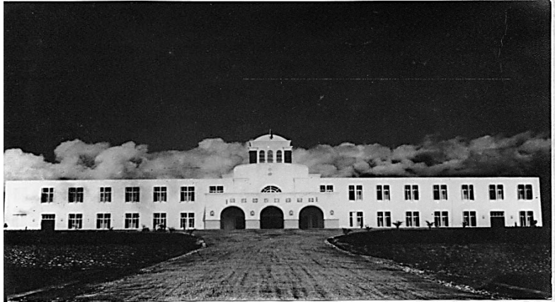
花蓮地方法院新辦公大樓正面
